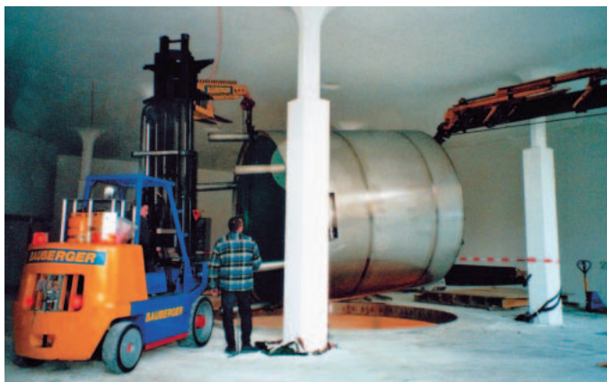
Barellen-Einsatz an Fassadenöffnung. 7-t-Gas-Gabelstapler, Bauhöhe 1,97 m, Fahrzeugbreite 1,44 m
